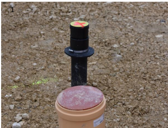
1 et 2 : Joint « Frank » avec collier de serrage pour passage de conduites verticales à travers un radier neuf (photo : ©croqAIR, HEIA-FR). Situation avant le ferrillage.
