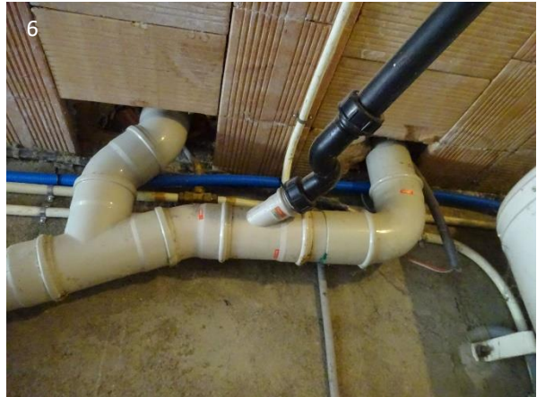
1 : introduction d'eau potable traversant le radier. 2 : introduction d'eau potable dans une cave en terre battue avec murs enterrés en moellons, séparation avec l'habitation par un plancher en bois non étanche. 3 : introduction de gaz à travers un mur enterré. 4 : canalisation d'eau usée traversant la dalle au sous-sol. 5 : gaine technique reliant les étages avec le sous-sol. 6 : passages de conduites (eau potable, électricité et colonnes de chute) à travers une dalle en hourdis de briques terre cuite non étanche séparant le sous-sol de l'habitation. (photos : ©Effiteam Sàrl)
