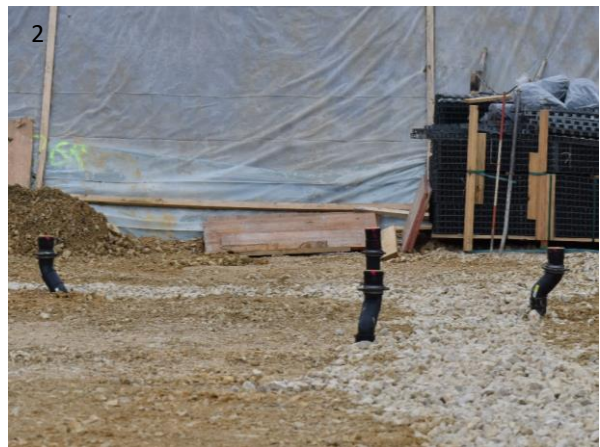
1 et 2 : Joint « Frank » avec collier de serrage pour passage de conduites verticales à travers un radier neuf (photo : ©croqAIR, HEIA-FR). Situation avant le ferrillage.
