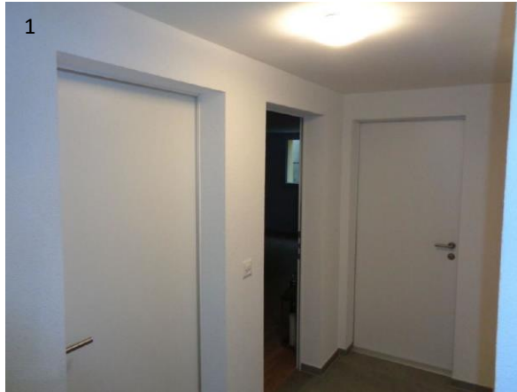
1 : Portes étanches d'accès au sous-sol vers des espaces non chauffés (ne pas utiliser de seuil abaissable ; seul un cadre de porte complet, avec des joints périphériques de calfeutrement sur tout le pourtour est efficace) ; 2 : Etanchéité à l'air et raccords pour passages de conduites (photo : ©Effiteam Sàrl)
