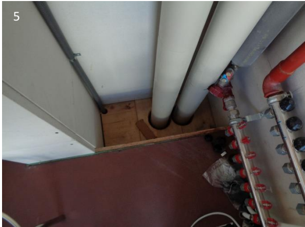
1 : introduction d'eau potable traversant le radier. 2 : introduction d'eau potable dans une cave en terre battue avec murs enterrés en moellons, séparation avec l'habitation par un plancher en bois non étanche. 3 : introduction de gaz à travers un mur enterré. 4 : canalisation d'eau usée traversant la dalle au sous-sol. 5 : gaine technique reliant les étages avec le sous-sol. 6 : passages de conduites (eau potable, électricité et colonnes de chute) à travers une dalle en hourdis de briques terre cuite non étanche séparant le sous-sol de l'habitation. (photos : ©Effiteam Sàrl)
