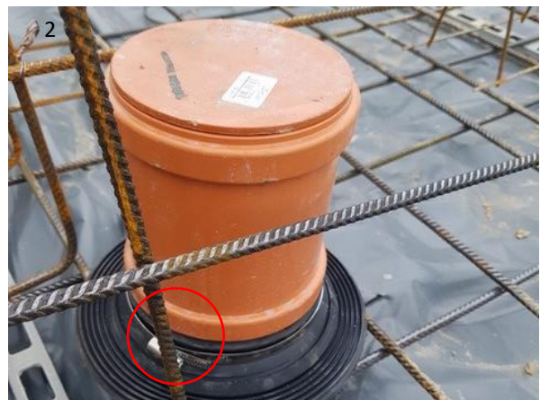
1 : Joint « Frank » avec collier de serrage pour passage de conduites verticales à travers un radier neuf (photo : ©croqAIR, HEIA-FR). Situation avant le coulage du radier. Vérifier la hauteur de fixation des joints sur les tubes pour qu'ils soient bien enrobés dans le béton (joint trop haut sur la photo). 2 : Contrôler que les 2 colliers de serrage présents sur chaque joint aient été vissés pour garantir l'étanchéité (non serré sur la photo).
