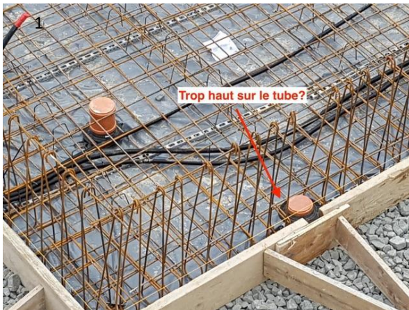
1 : Joint « Frank » avec collier de serrage pour passage de conduites verticales à travers un radier neuf (photo : ©croqAIR, HEIA-FR). Situation avant le coulage du radier. Vérifier la hauteur de fixation des joints sur les tubes pour qu'ils soient bien enrobés dans le béton (joint trop haut sur la photo). 2 : Contrôler que les 2 colliers de serrage présents sur chaque joint aient été vissés pour garantir l'étanchéité (non serré sur la photo).
